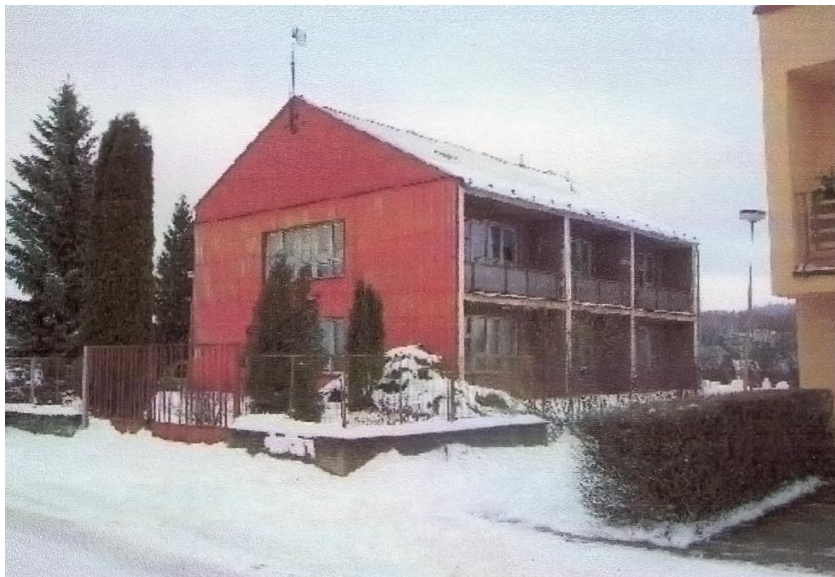
Obrázek č. 1: Stav před rekonstrukcí
