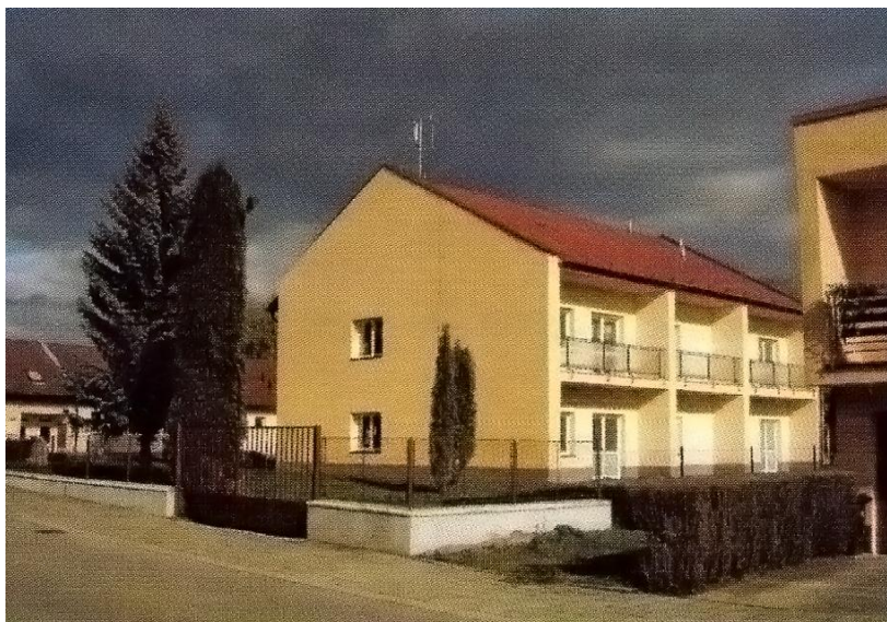
Obrázek č. 2: Stav po rekonstrukci
