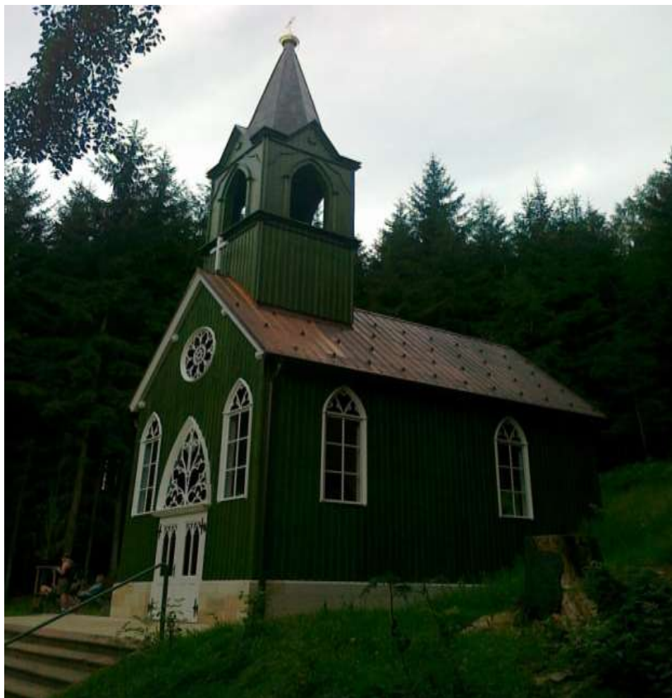
Obrázek 4: Ticháčkova kaple u Suchého Dolu
