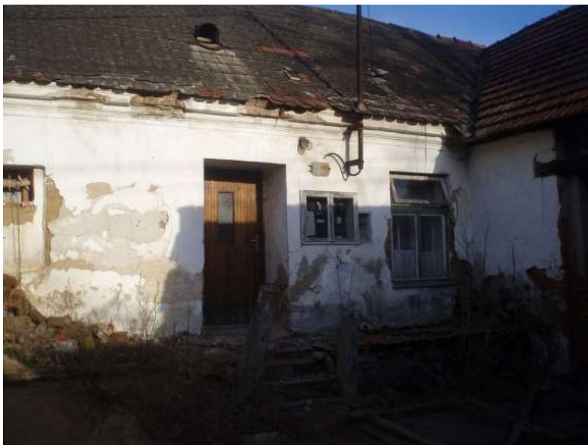
Obrázek 1 Dům před rekonstrukcí (Obec Dolní Vilémovice, 2019)
