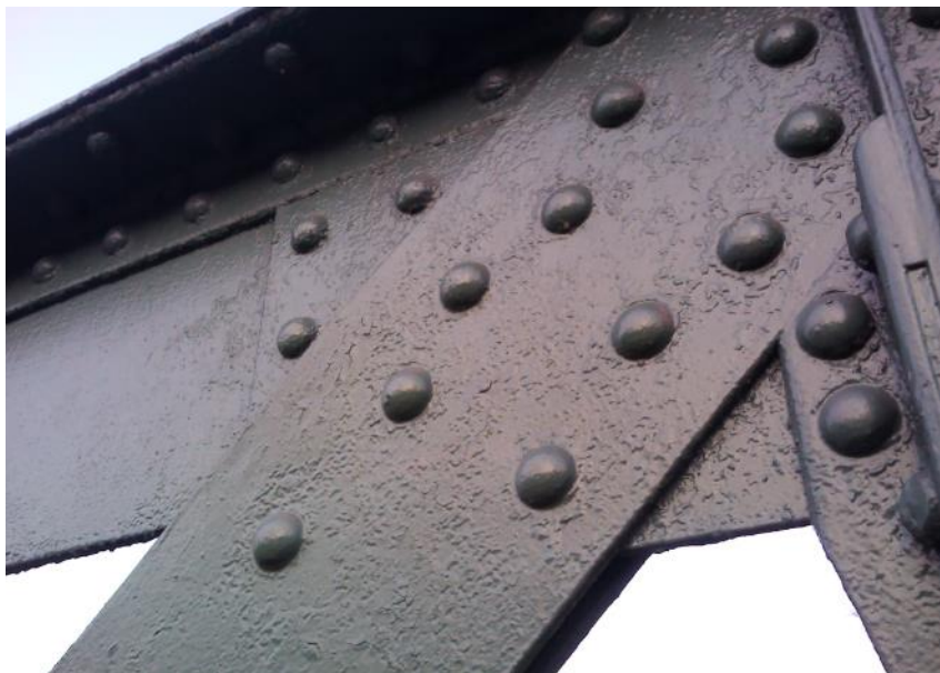
Obrázek 4 Nýtový spoj konstrukce
