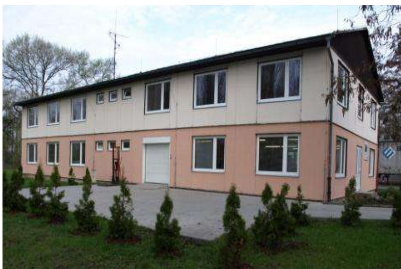
Obr. 6: Budova chráněné dílny
