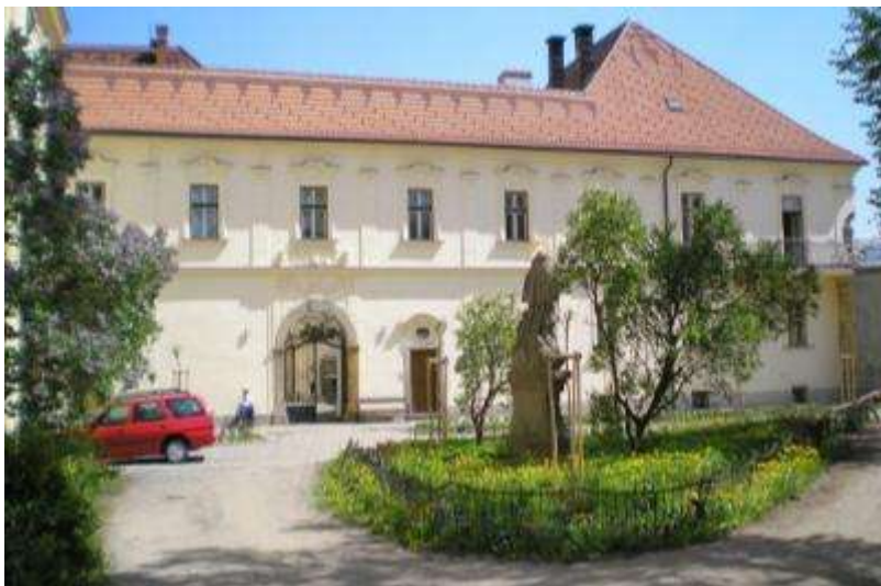
Obr. 3: Budova chráněné dílny
