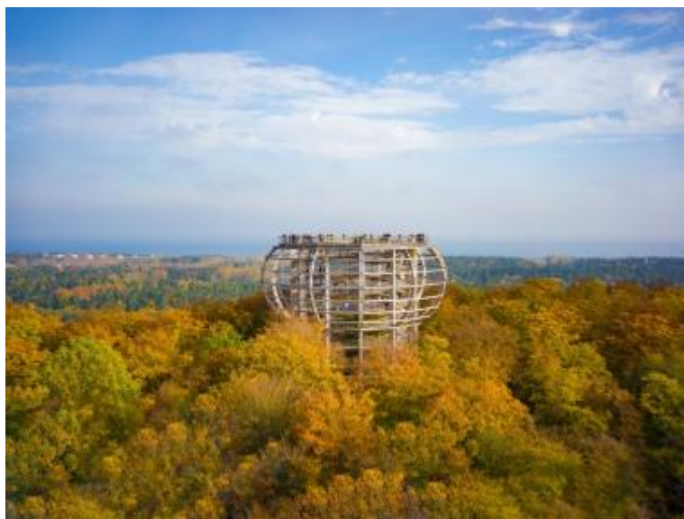
Obrázek 3: Stezka korunami stromů Rügen
